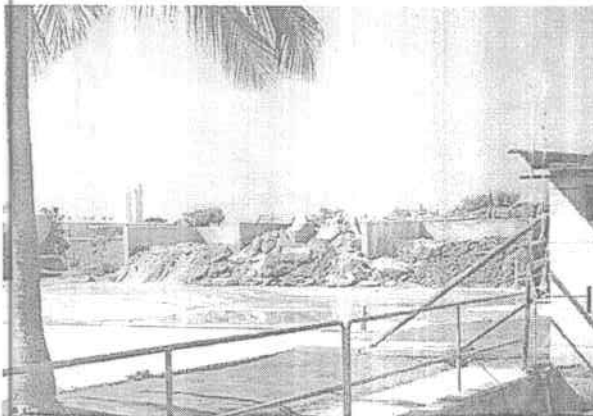
Foto 7. Zona de almacenamiento temporal de arena y concreto endurecido.
