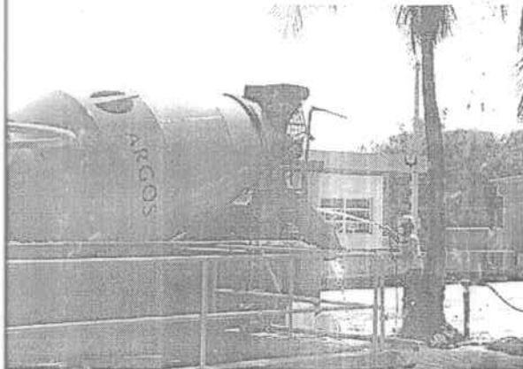
Foto 6. Lavado de los Mixers con agua
